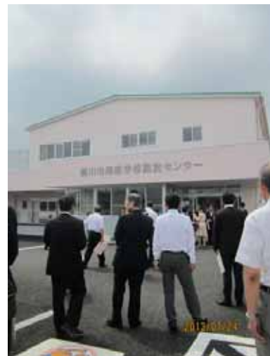
給食センター外観
